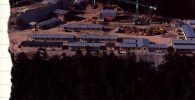
Il cantiere per la costruzione della diga sul fiume Menta, in Calabria. In basso: la facciata di una caserma a Roma.
