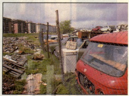
L'ex aeroporto di Centocelle, a Roma (una delle aree destinate allo Sdo). Nella pagina accanto, in alto: ruspe al lavoro sull'Alpe di Siusi
