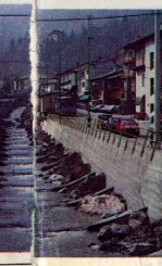
Un tratto del fiume Po con gli argini cementificati a pochi chilometri dalla sorgente.
