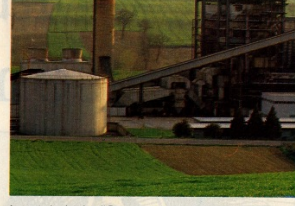
La centrale elettrica di Bastardo in provincia di Perugia.
