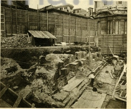
14. Scavo della Biblioteca a lato della Colonna Traiana (a d. si vedono le fondazioni dei pilastri in cemento che la sotterreranno) (1932).
