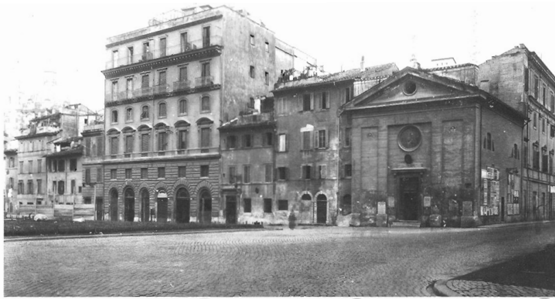
Fig. 17 - Fronte degli edifici su via della Croce Bianca: a destra la chiesa di S. Maria in Macello Martirum, all'angolo con via Alessandrina (cfr. fig. 16, nn. 1-3) (foto Gabinetto Stampe e Disegni del Comune di Roma).
