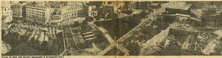
Così le fasi dei lavori secondo il progetto Fori
