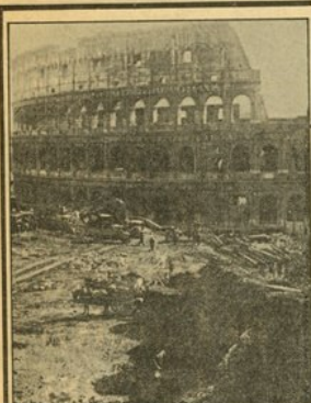
La zona del Fori durante i lavori di demolizione, Roma, 1932
