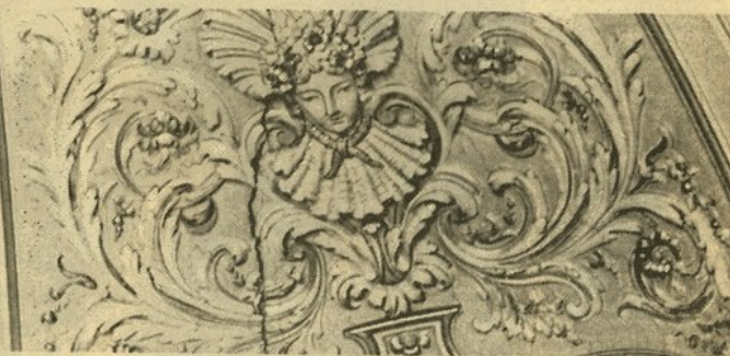
Gli stucchi e le crepe nella cupola della chiesa di San Celso in via del Banco di Santo Spirito
