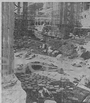
Così i lavori in via della Consolazione
