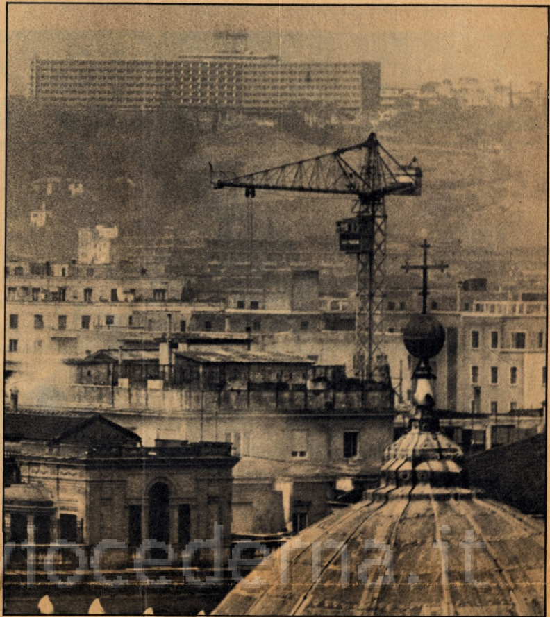
Roma. L'albergo Hilton in costruzione sulla cima di Monte Mario.
