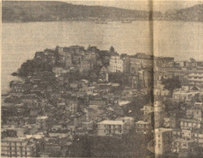
Una veduta generale della parte vecchia di Pozzuoli abbandonata a se stessa. (UP)
