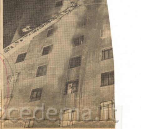
Tucson (Arizona, USA): ventidue persone, fra cui due bambini, hanno pe... vicino all'edificio scoppio in piena notte fra i...
