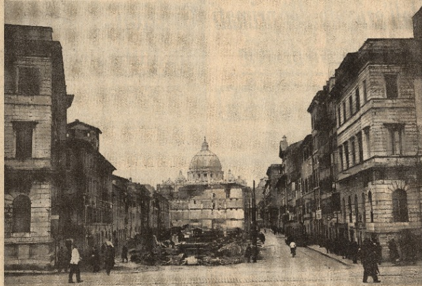
Roma 1937: la demolizione dei vecchi borghi in vista della nuova via della Conciliazione
