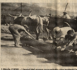
Littoria (1939) - I lavori del nuovo acquedotto che porterà l'acqua da capo Ninfia alla città
