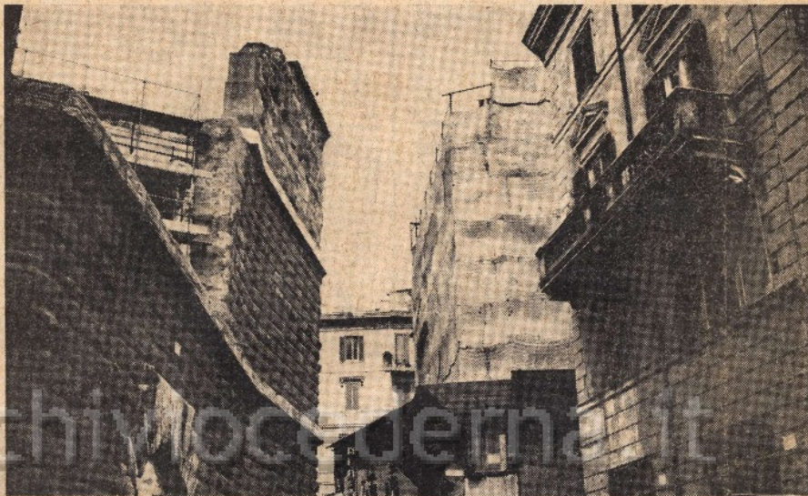
ROMA — Un palazzo «fasciato» dalle impalcature edili. Nel centro della capitale sono all'opera oltre cento cantieri che restaurano antichi palazzi per trasformatli in abitazioni di lusso o uffici direzionali. (Foto Giuliani)
