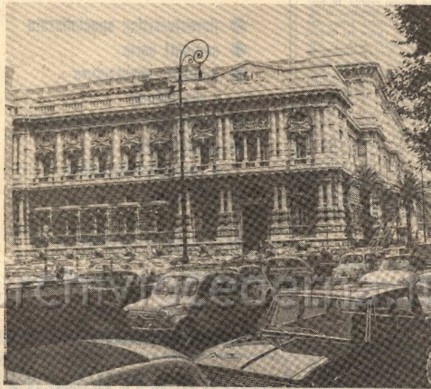
Il «Palazzaccio» di piazza Cavour da consolidare e restaurare
