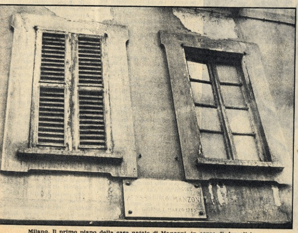
Milano. Il primo piano della casa natale di Manzoni, in corso di demolizione.
