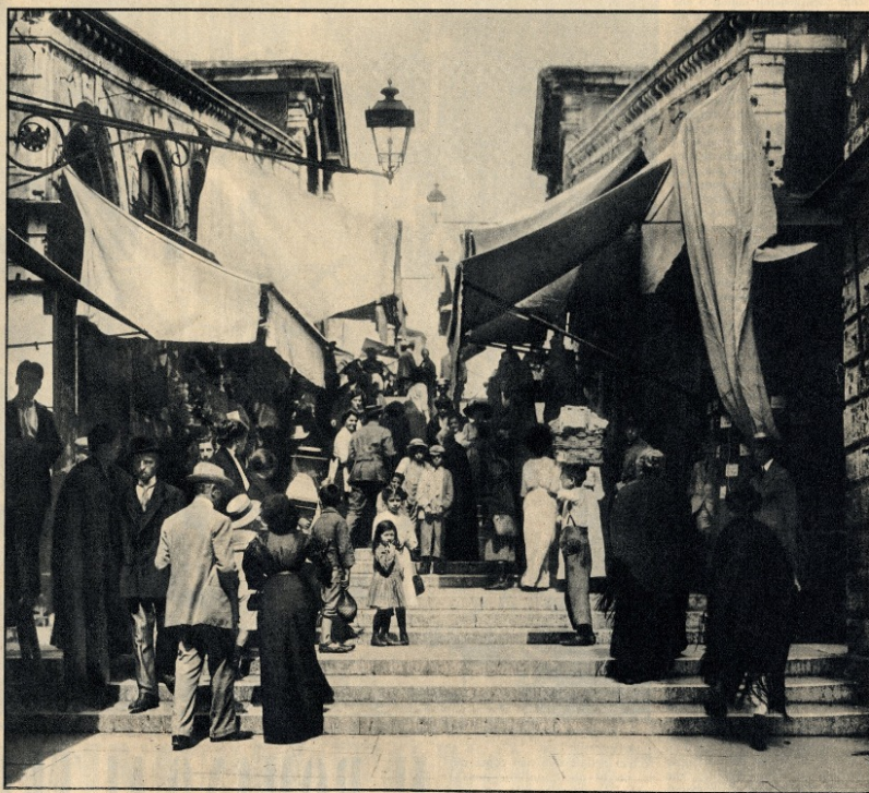
Venezia 1900. La scalinata del Ponte di Rialto.
