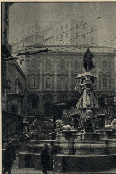
Napoli, piazza di Monteliveto. Si iniziano i lavori per l'elmirinale
