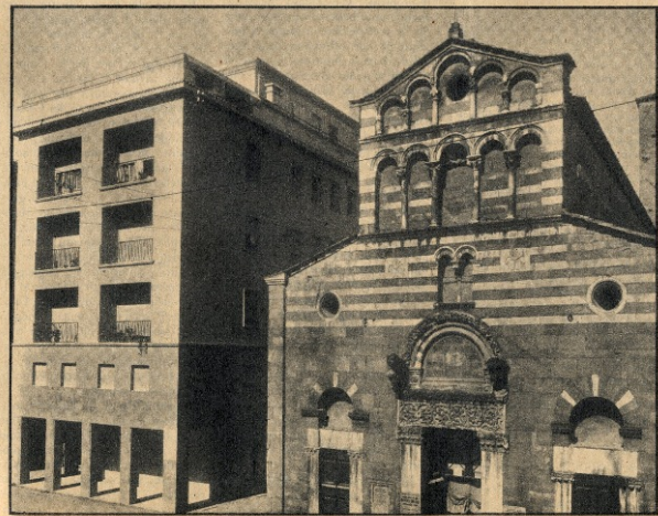
Lucca. Il nuovo palazzo funzionale sorto accanto alla chiesa di San Giusto.
