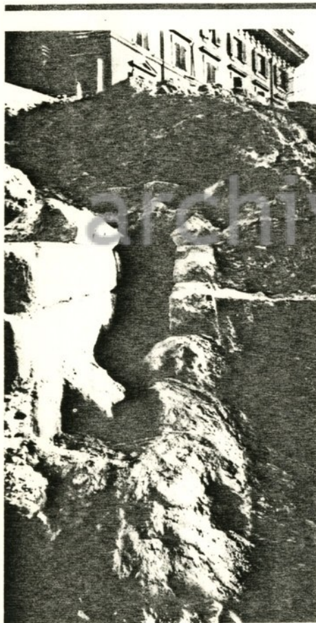
Una cloaca di età repubblicana, in blocchi di tufo disposti a volta arcuata, sta per essere distrutta all'angolo di via della Polveriera. I lavori di sbancamento della Velia non furono neppure accompagnati dal rilevamento di quanto si andava abbattendo. A fornirci un'idea della vastità delle demolizioni ci resta solo una episodica documentazione fotografica.
